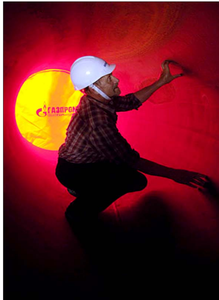
Un trabajador de Gazprom revisa un tramo de tubería durante la construcción del gasoducto nórdico-europeo, en la región de Leningrado ■ Imagen de RIA Novosti tomada del sitio en Internet fr.rian.ru
