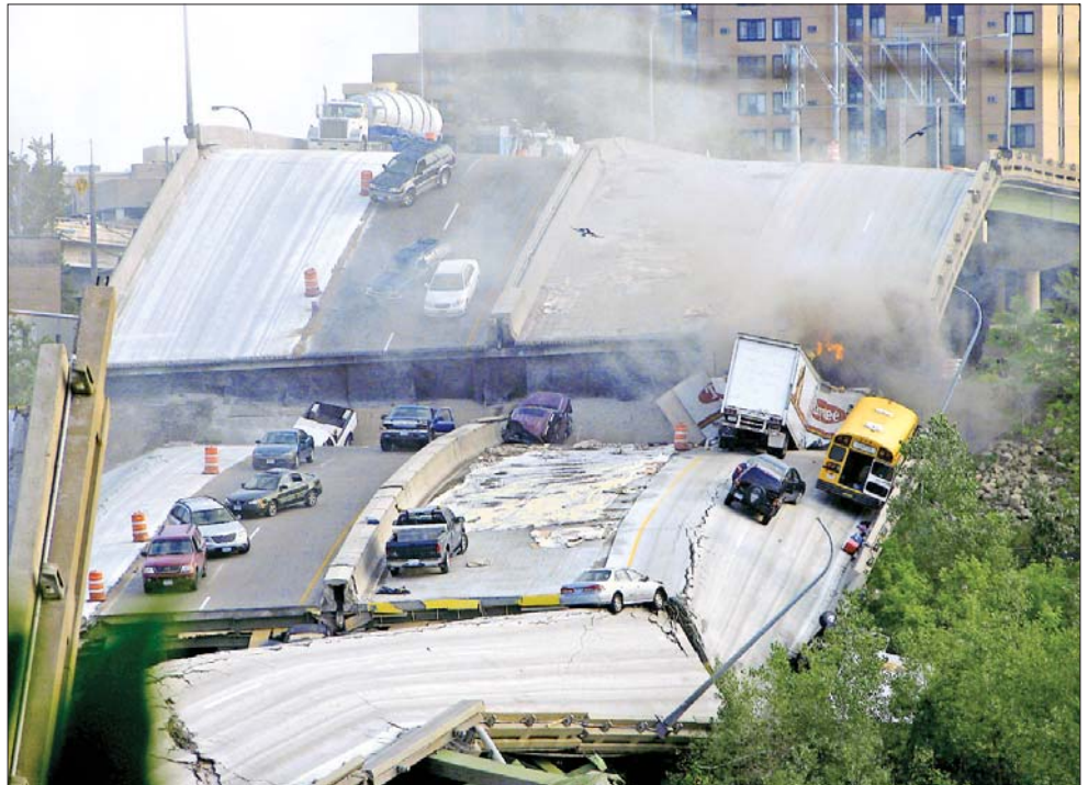
Al menos siete personas murieron y 60 resultaron heridas al colapsarse la estructura. Además, decenas de conductores quedaron atrapados sobre enormes pedazos de hormigón. El puente conectaba las ciudades gemelas de Minneapolis y Saint Paul, en el estado de Minnesota. La vía, con 150 metros de extensión y ocho carriles, estaba en reparación y al momento del desastre se encontraba repleta de vehículos, cerca de las 18 horas locales. Las autoridades descartaron una acción terrorista ■ Ap
