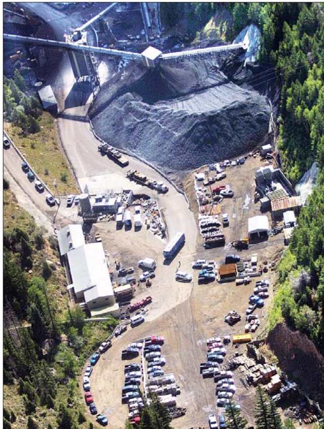
Vista de la mina Crandall Canyon, en la localidad de Huntington, Utah, la cual se colapsó y atrapó a seis trabajadores ■ Ap
