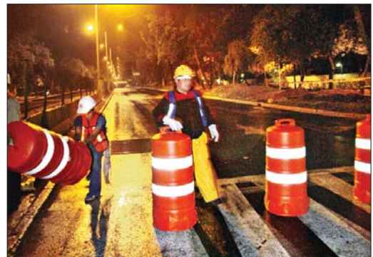
Los carriles centrales de Río Churubusco, en su entronque con avenida Cuauhtémoc, fueron cerrados a la circulación ayer, a las 23 horas, para la construcción de un puente vehicular. Las vías laterales permanecerán abiertas ■ Foto Carlos Cisneros
