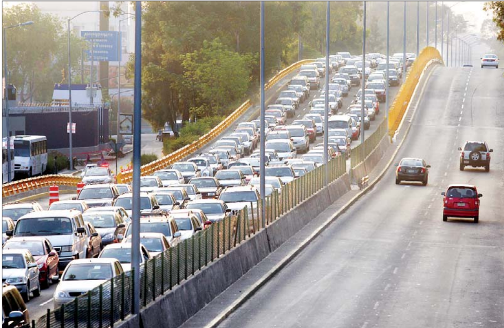
El cierre de los carriles centrales de la arteria en su tronque con avenida Cuauhtémoc —en sentido de oriente a poniente—, para la construcción de un puente, causó un enorme caos vial en más de dos kilómetros. En los siguientes días se aplicarán las mismas medidas en dirección al aeropuerto. Con la intención de atenuar efectos se destinarán 350 agentes para agilizar el tránsito ■ Foto Carlos Ramos Mamahua
