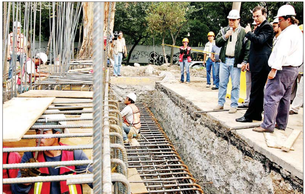
El jefe de Gobierno del Distrito Federal, Marcelo Ebrard, supervisó el avance del puente que se construye sobre Río Churubusco, en el cruce con México Coyoacán-Centenario ■ Fotos María Luisa Severiano
