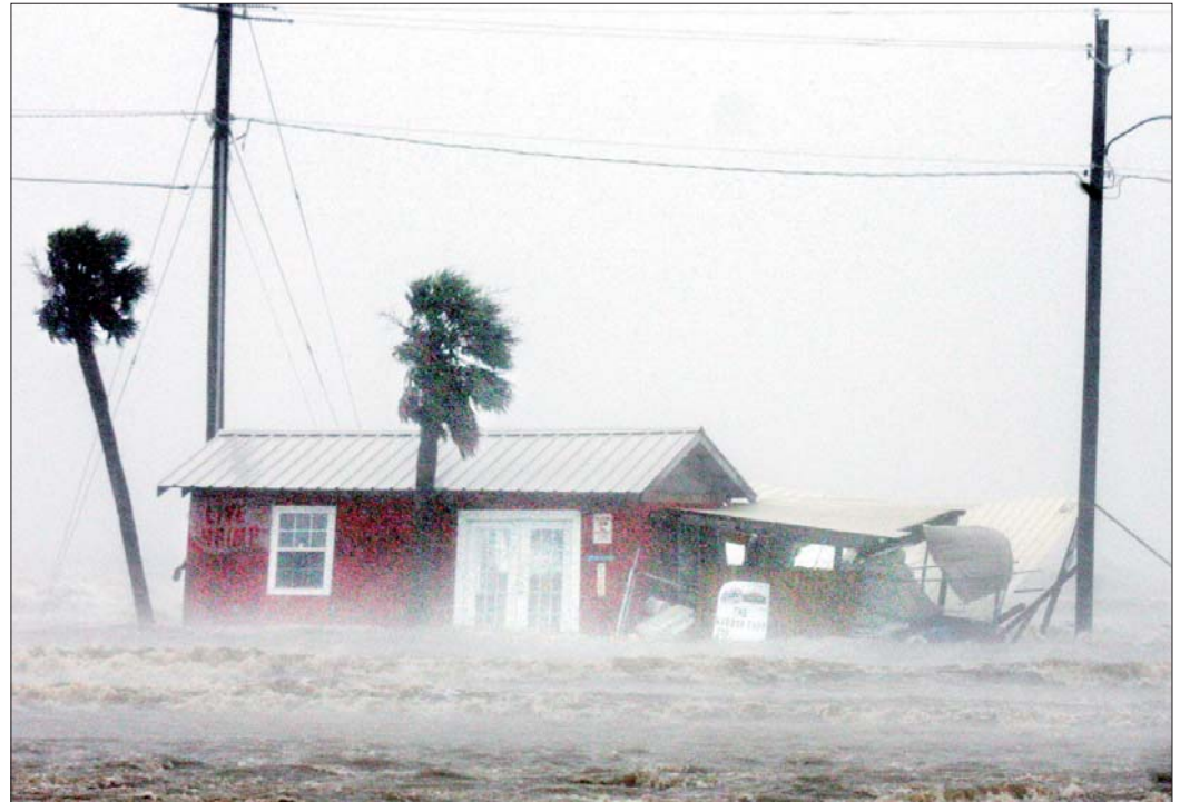
El huracán entró con menos fuerza de lo previsto y provocó que dos diques que protegen a la ciudad cedieran parcialmente a la marea, lo que generó algunas inundaciones en la zona castigada por Katrina , hace tres años. El meteoro se degradó a categoría uno, con vientos hasta de 145 kilómetros por hora. La elevación de las aguas y los apagones afectaron a unas 700 mil personas. La imagen corresponde a un comercio en Gulfport. En Cuba, el ex presidente Fidel Castro dijo que el golpe de Gustav a la producción de alimentos "es costoso y sensible" ■ Foto Ap
