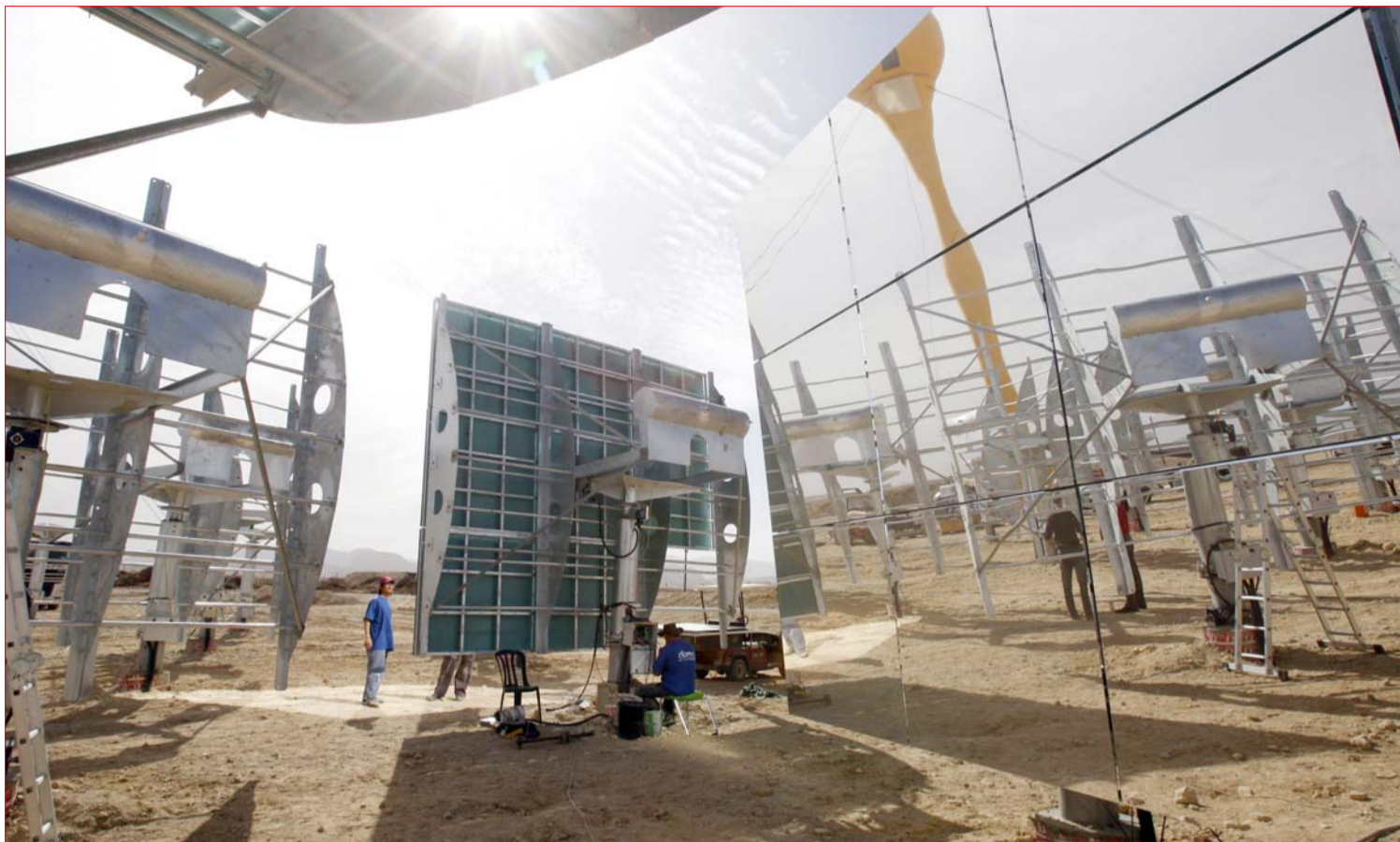
Especialistas israelíes durante la construcción de la primera planta de energía solar híbrida ■ Foto Reuters
