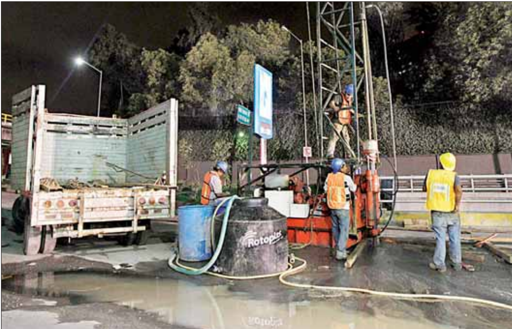
Las obras del segundo piso del Periférico –a cargo de la empresa española OHL– en el cruce con Paseo de las Palmas fueron suspendidas desde la madrugada del jueves luego que durante los trabajos de excavación se detectó una probable fuga de hidrocarburo ■ Foto Yazmín Ortega
