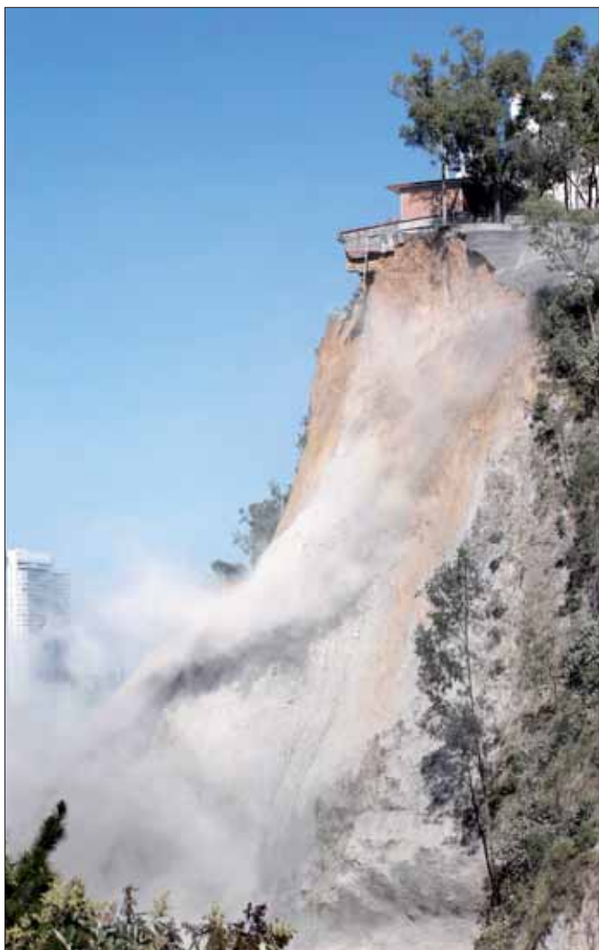
Momento del deslave de ayer en el talud del fraccionamiento Vistas del Campo, en Santa Fe. Vecinos afectados señalaron que persisten los riesgos por la humedad en el cerro, la cual afecta a varios edificios ■ Foto Carlos Ramos Mamahua
